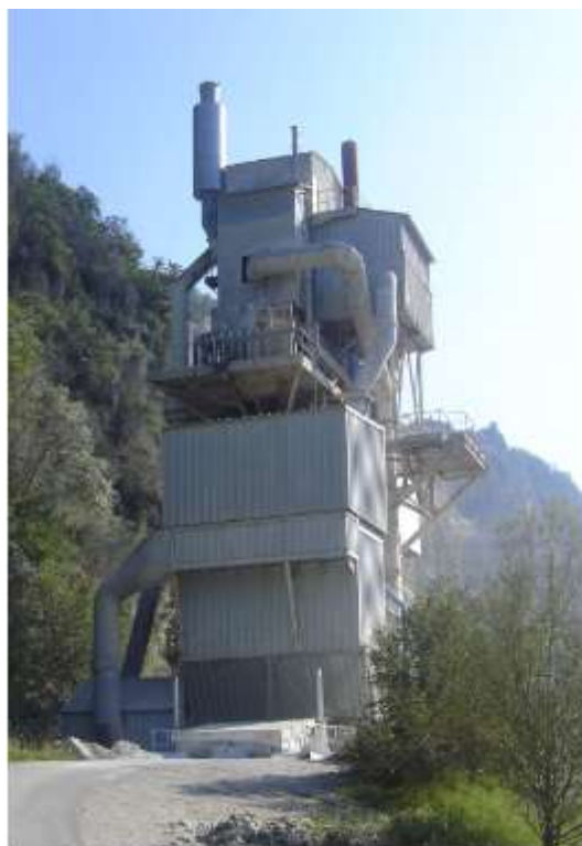
Figure 4 : photographie du four
